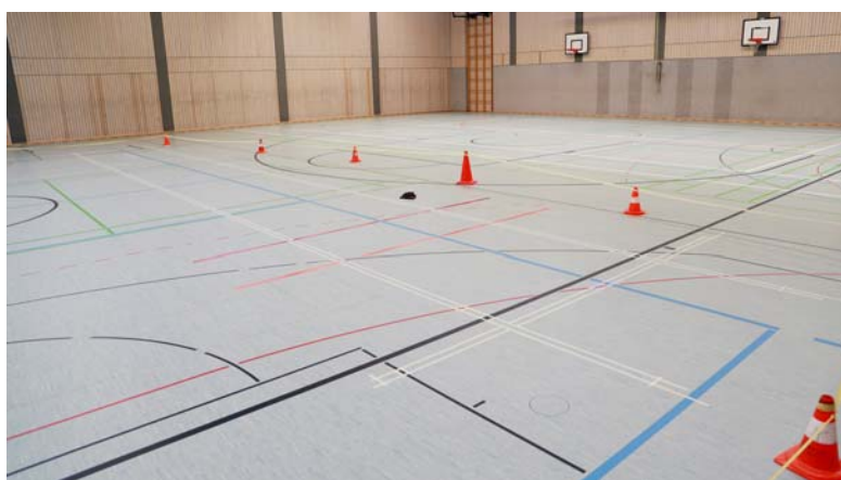
Der Boden der Drei-Felder-Halle wurde intensiv gereinigt und neu versiegelt.
