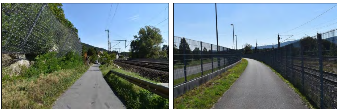
Abb. 3 Bestandssituation Saaleradweg (Remschütz – Schwarza)
