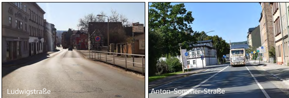
Abb. 13 Fehlende Radverkehrsanlagen im Verlauf der Bundesstraßen in Rudolstadt
