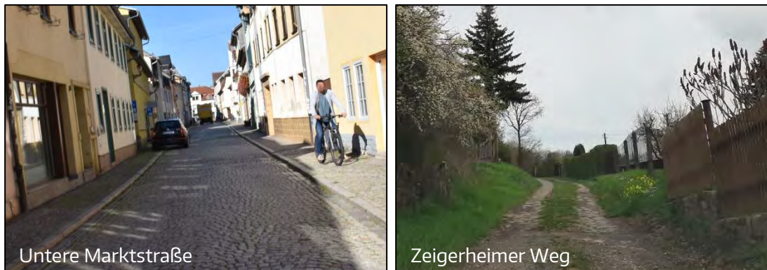
Abb. 12 Oberflächendefizite in Bad Blankenburg
