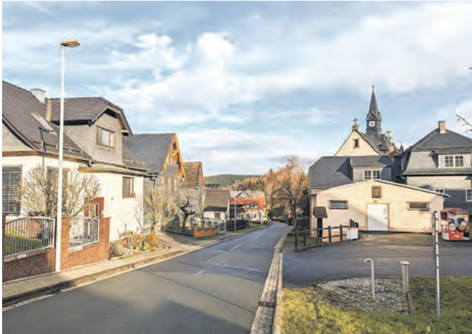
In Volksmannsdorf wurde innerörtlich die Straße einschließlich der Entwässerung neu gebaut.
