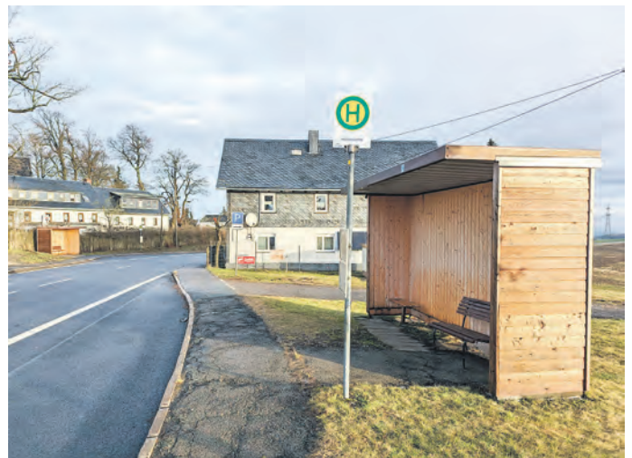
Die zwei Buswartehäuschen in Hoheneiche wurden vom städtischen Bauhof erneuert.
