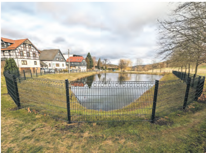
In vielen Ortsteilen war es notwendig, die Feuerlöschteiche mit einer Einzäunung zu sichern. So wurde um die Feuerlöschteiche in Braunsdorf, Dittersdorf, Eyba, Gösselsdorf, Jehmichen, Kleingeschwenda, Volkmannsdorf und Wittmannsgereuth ein Zaun errichtet.
