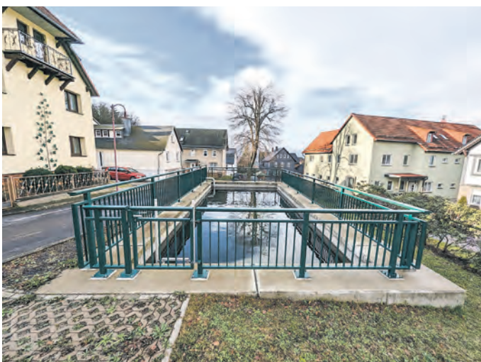
Die Feuerlöschteiche in Burkersdorf, Dittrichshütte, Reichmannsdorf und Wittgendorf die sich in einem desolaten Zustand befanden, wurden in die Kur genommen und von Grund auf saniert. Die Instandsetzung der Teiche war erforderlich, da es keine andere Möglichkeit zur Löschwasserbereitstellung gab.
