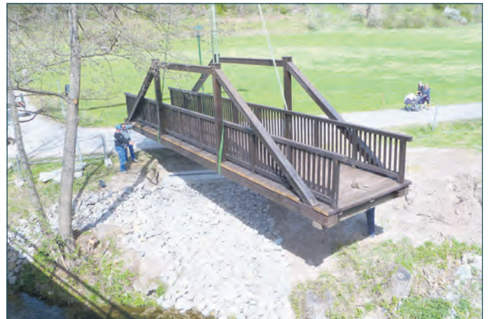
Nun war es endlich soweit. Die Stadtweg-Brücke wurde mittels Kran an ihren neuen Standort über den Schaalbach eingehoben. Noch sind einige Anpassungsarbeiten notwendig, die Verkehrsfreigabe soll aber spätestens Anfang Mai erfolgt sein.
