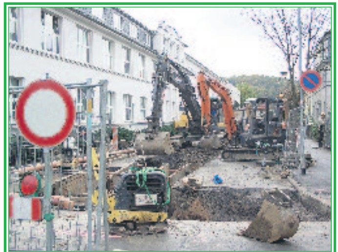
Zur Verlegung des Hauptsammlers durch den Zweckverband Wasser/Abwasser wird die Cumbacher Straße noch mehrere Monate gesperrt bleiben. Eine neu mit einer Schwarzdecke ausgebaute Umfahrung der Baustelle im Ortsteil Cumbach ist seit Mitte Oktober über die Straße Am Gänsebach möglich.
